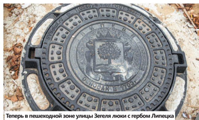
Теперь в пешеходной зоне улицы Зегеля люки с гербом Липецка
